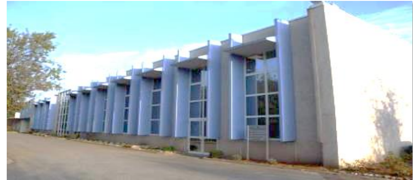
Centre de recherche & usine de production à Sophia-Antipolis (06)
